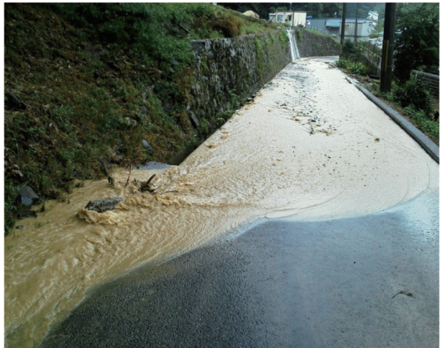
道路を流れる泥水（平成24年8月14日9時頃）
