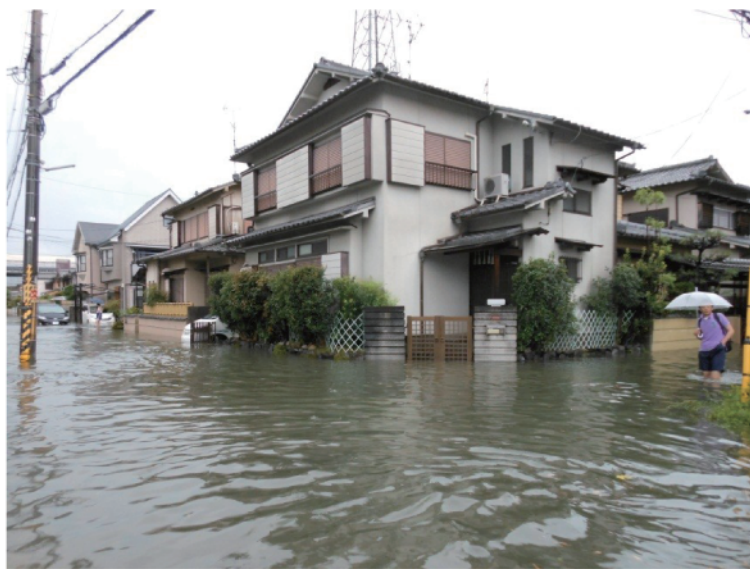
浸水した家屋（平成24年8月14日7時頃）
