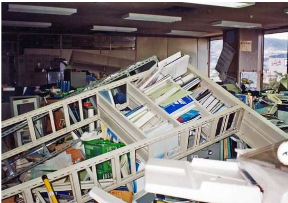
図表8 阪神・淡路大震災における西宮市役所の執務室及び廊下の状況
