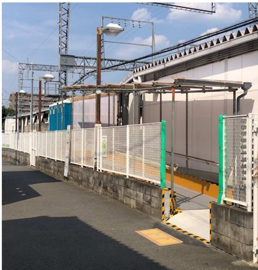
仮設スロープ状況 (京都市行)
