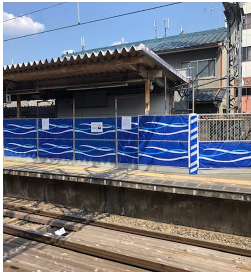
仮囲い状況 (大和西大寺行方面ホーム)
