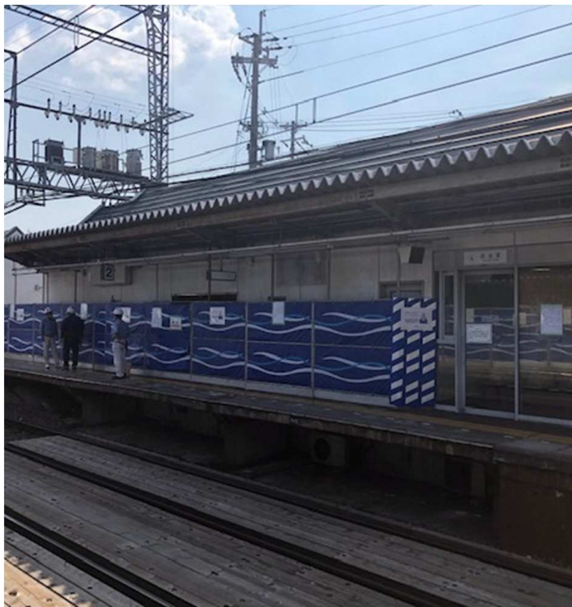
仮囲い状況 (京都行方面ホーム)
