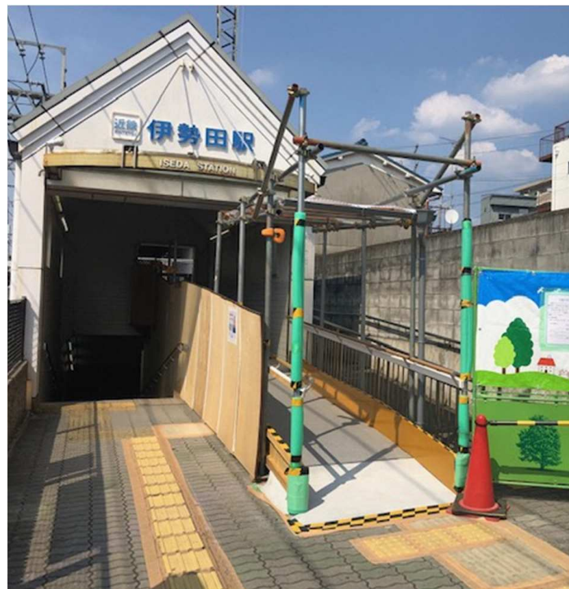
仮設スロープ状況 (大和西大寺行)
