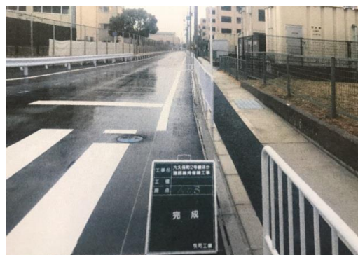
大久保町2号線（歩道改修工事）
