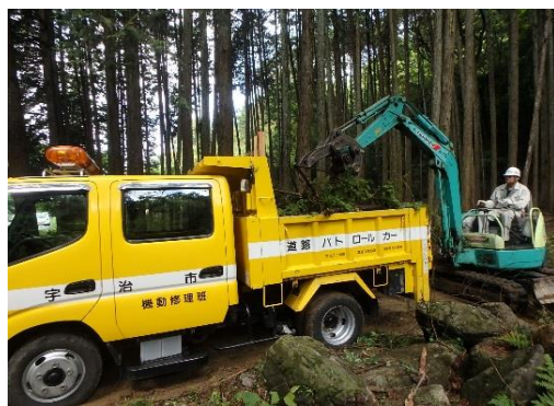
機動修理班による作業状況
