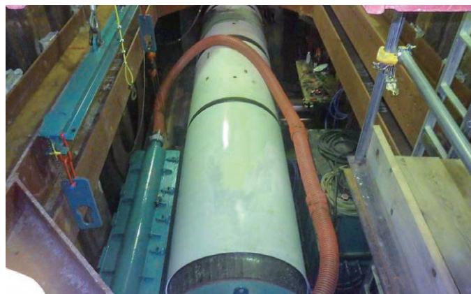
基幹管路の耐震化(シールド工法による施工)
