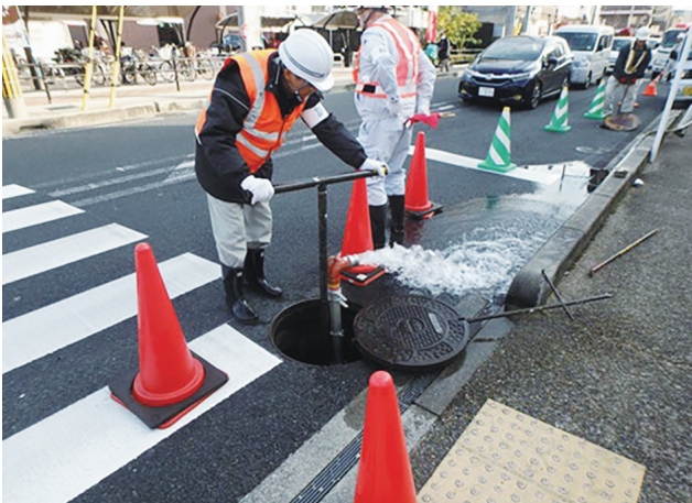
京都府営水道緊急分水施設(伊勢田町)での訓練
