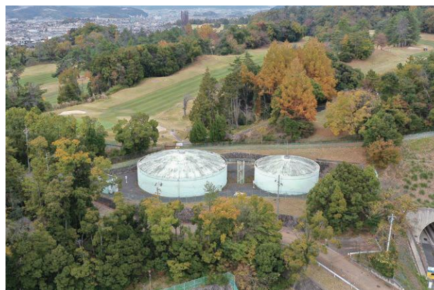
高峰山配水池
