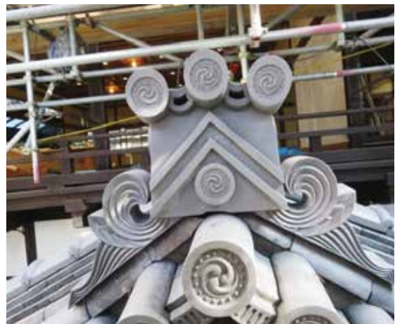
図 4-83 玄関屋根獅子口設置状況
