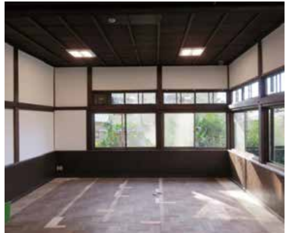
图 4-115 1階研修室2造作完了状況
