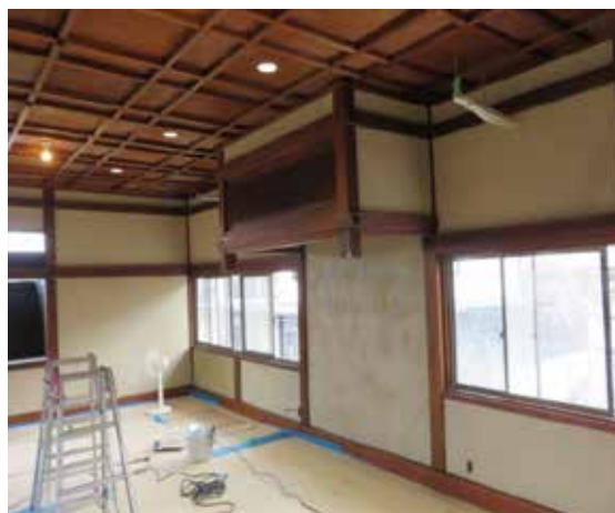
図 4-99 2階会議室壁新築塗り状況
