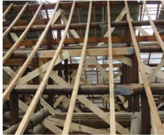
図 4-61 母屋補強状況
