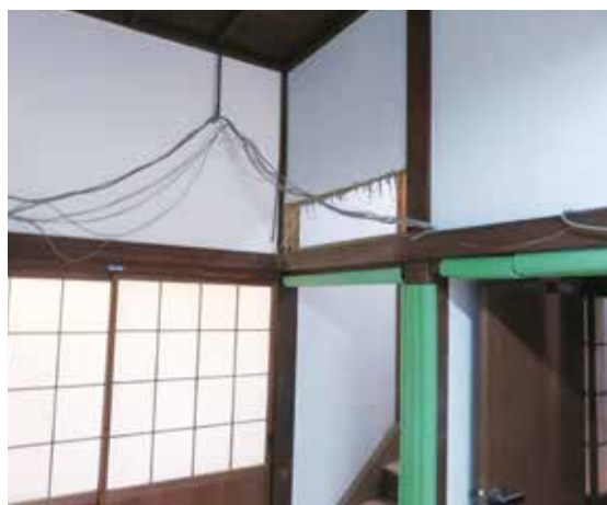
図 4-85 階段室垂壁高さ変更工事状況
