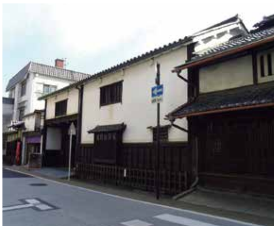
図 3-14 修理前（長屋門北面）
