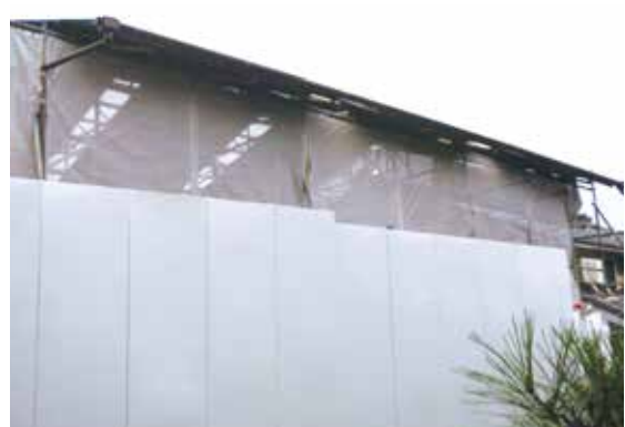
図 2-52 仮設工事 (南西側より)
