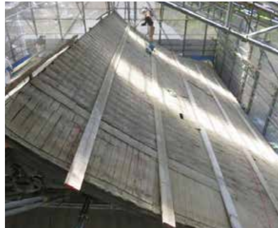
図 4-57 屋根解体状況 2
