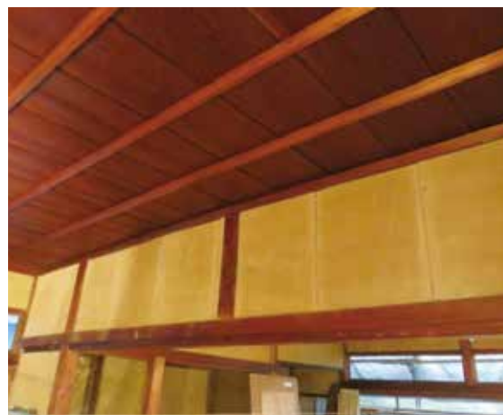
図 4-93 2階耐震壁構造補強垂壁の荒壁パネル張り
