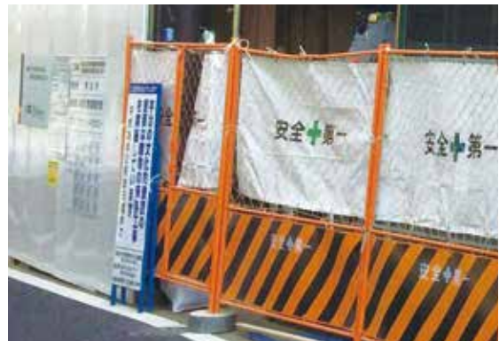
図 2-50 仮設工事 (外観 看板)
