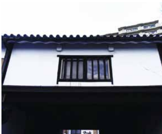
図 3-16 修理前（長屋門南面）
