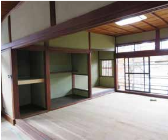
図 4-100 2階座敷壁新聚楽塗り状況
