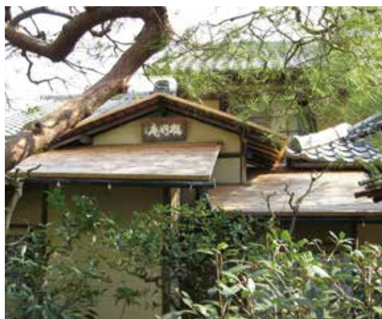
图 3-9 修理後（茶室北面）
