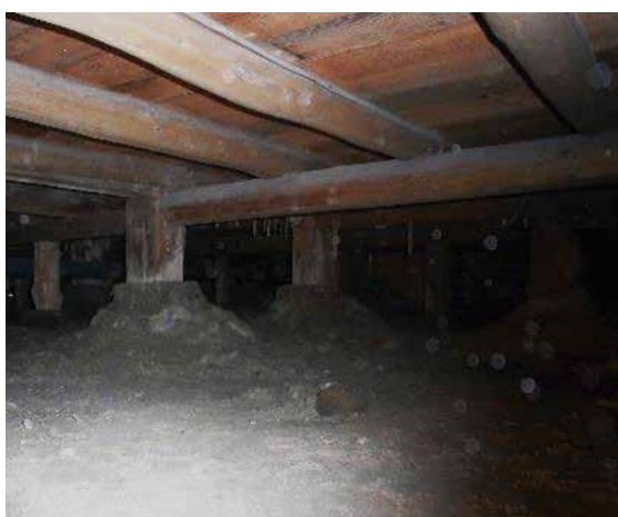
図 4-52 修理前（ひとつ石礎石の状況）
