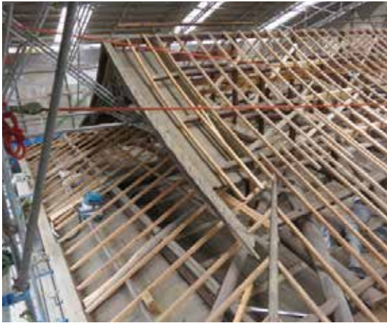
図 4-60 小屋組改修状況
