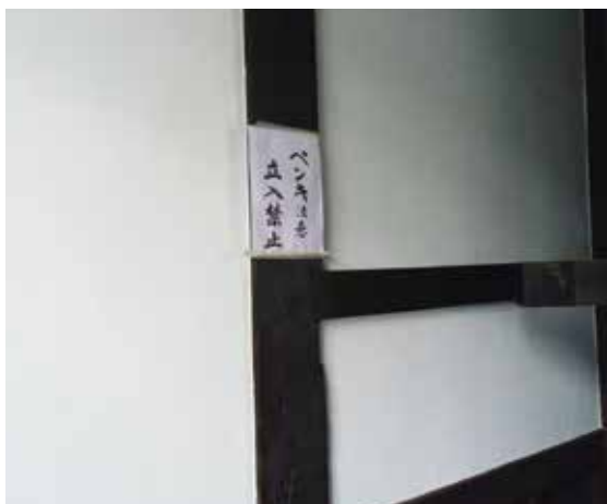
図 3-18 修理後（長屋門当て板取付）
