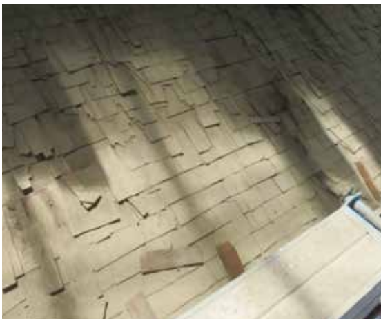
図 4-58 屋根解体状況 3
