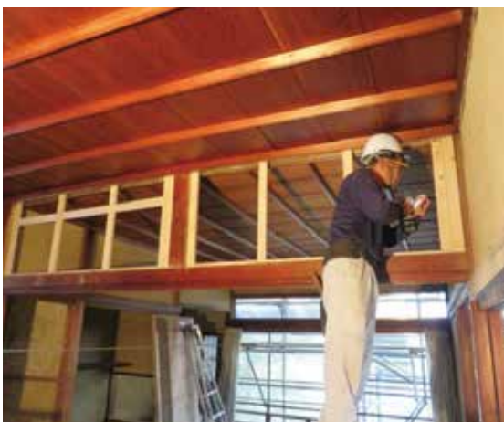
図 4-92 2階耐震壁構造補強の垂壁下地工事
