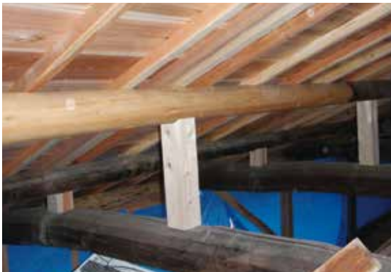
図 2-67 木工事（小屋束 梁）
