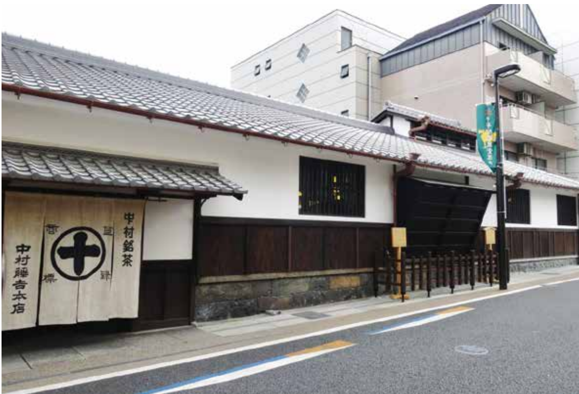
図 2-28 中村藤吉本店旧焙炉場修理後外観（東から、平成 27 年）
