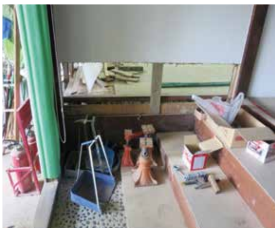
図 4-84 玄関腰壁耐震補強工事状況
