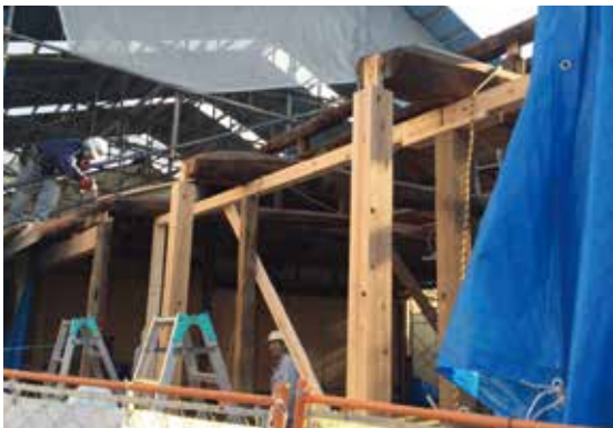
2-65 木工事（北西側より）
