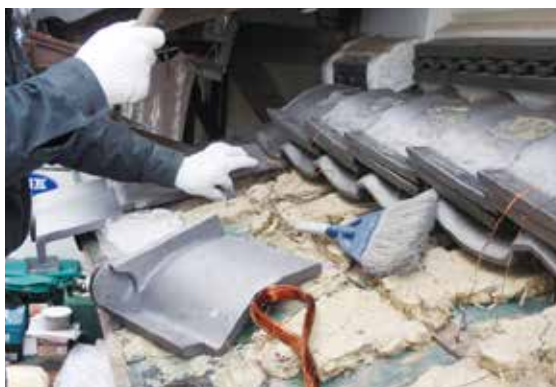
図 2-75 屋根工事 (北側庇)
