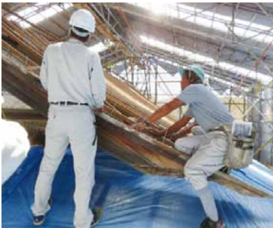
図 4-74 屋根反り瓦割り付け検査
