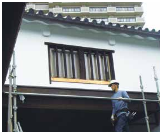
図 3-17 修理後（長屋門南面）
