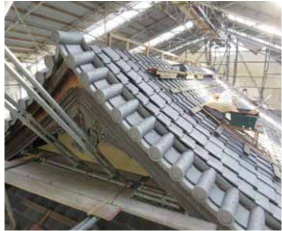
図 4-79 屋根瓦葺き状況 2
