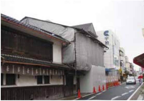
図 2-47 仮設工事 (外観 北東側より)
