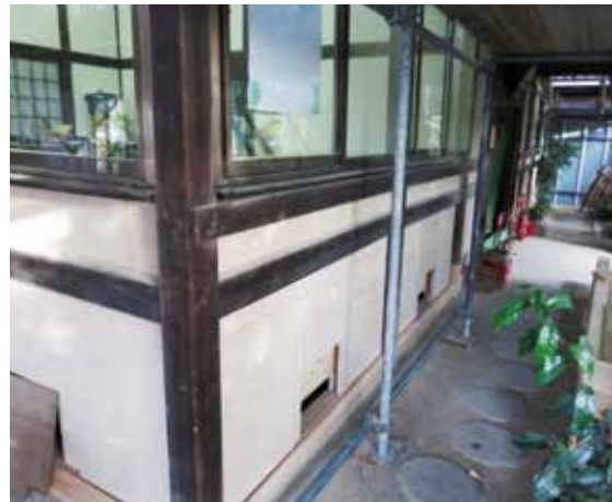
図 4-73 1階腰の柱根継・付け土台荒壁下地完了 2
