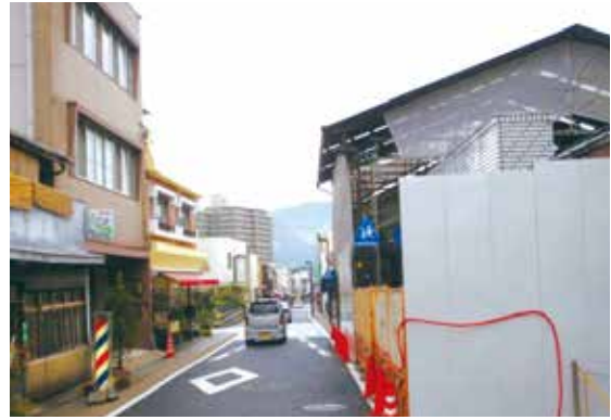
図 2-48 仮設工事 (外観 北西側より)
