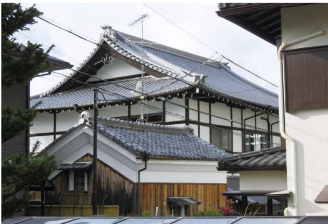
図 4-122 修理後外観（南東面）
