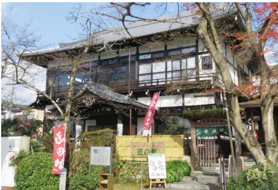
図 4-118 修理後外観（西面）
