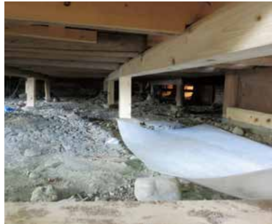
図 4-69 床組、大引及び床束の取替え状況
