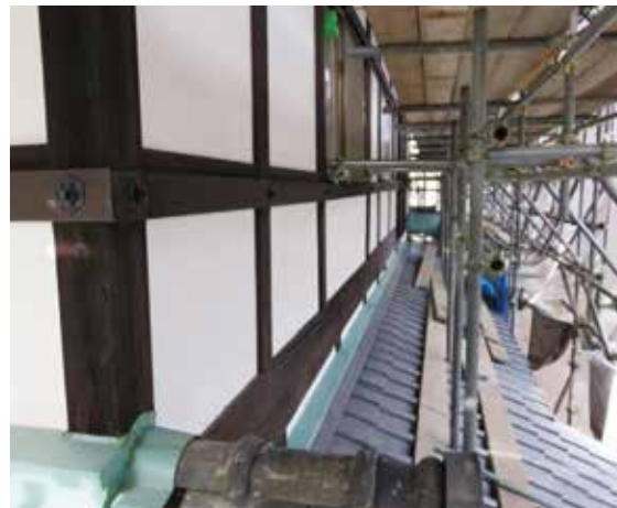
図 4-109 2階外壁漆喰塗り・木部古色完成 2
