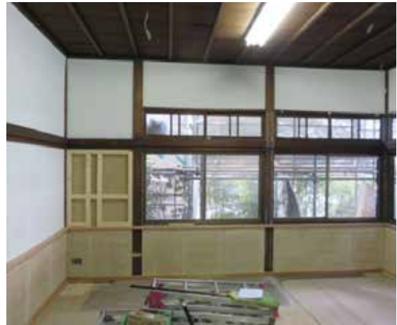
図 4-103 1階研修室2腰壁下地設置状況
