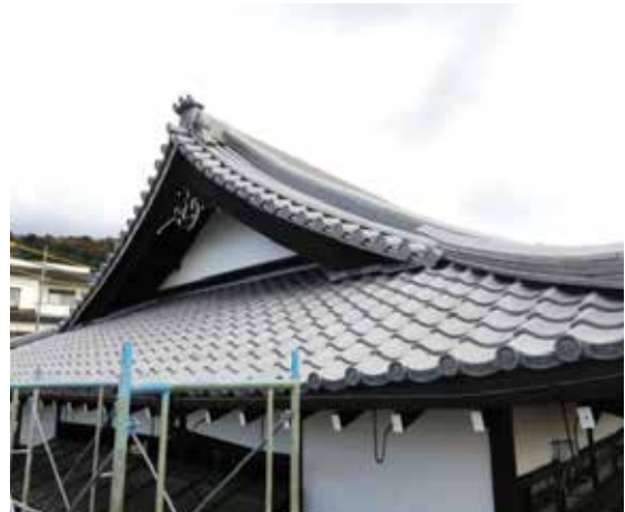
図 4-81 屋根瓦葺き完了状況
