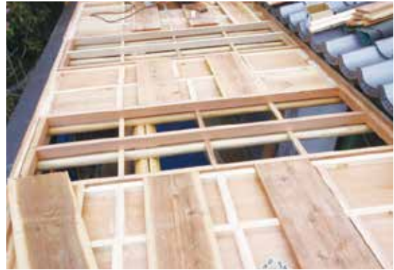
図 2-80 屋根工事 (中庭側庇)
