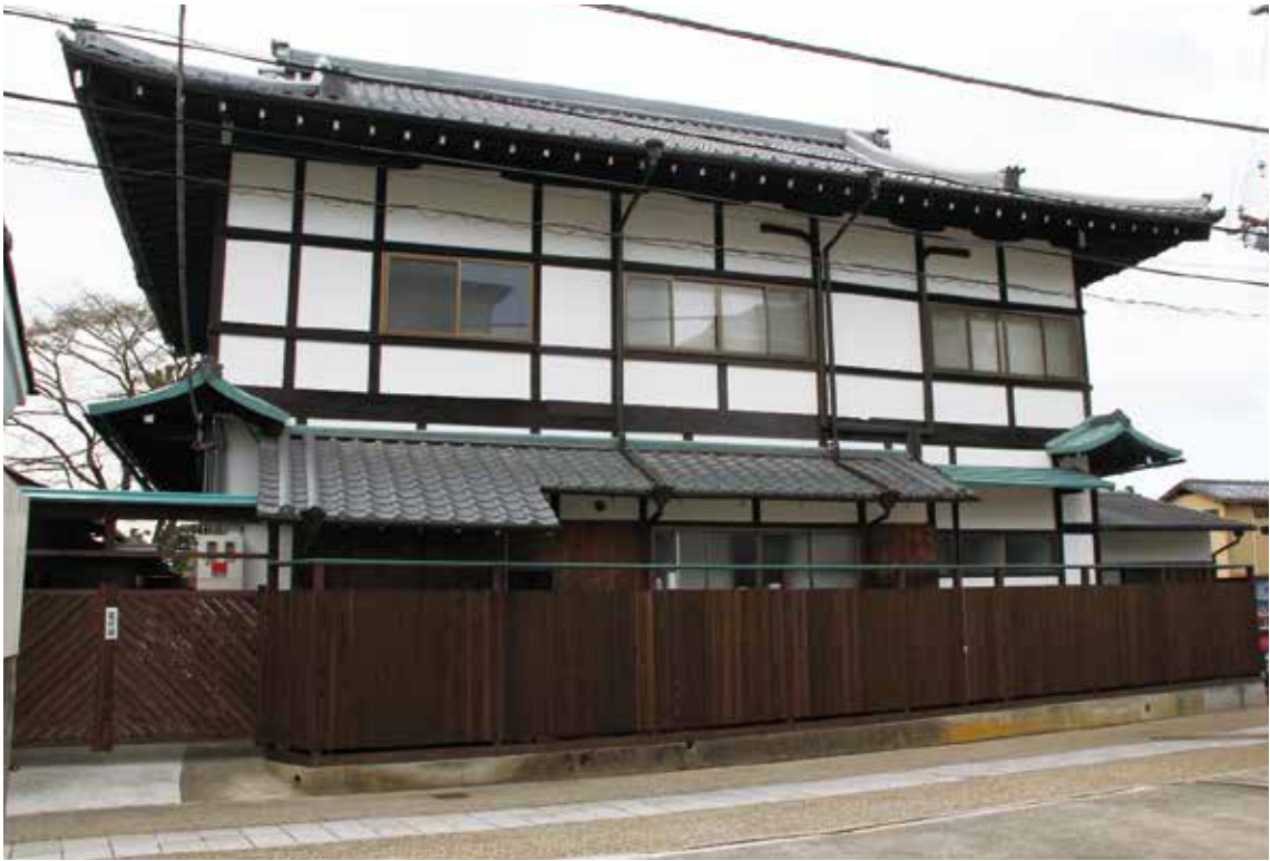
図 4-120 修理後外観（東面）
