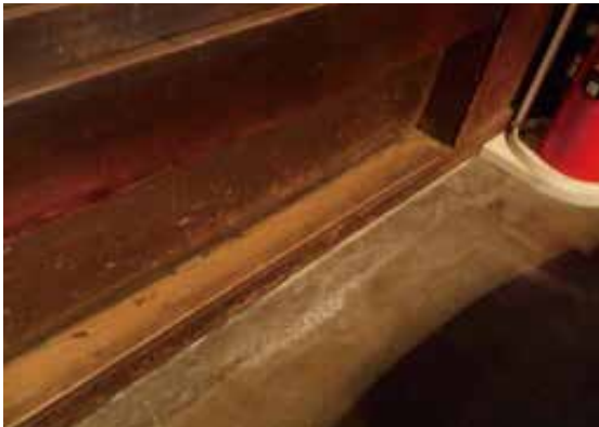
図 2-9 板壁下地胴縁の痕跡
