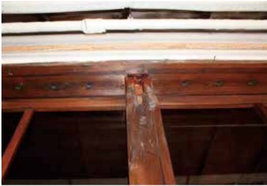
図 2-13 下見板の痕跡
