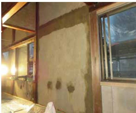
図 4-98 2階会議室壁下地処理状況
