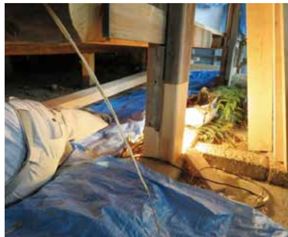
図 4-71 1階柱根継の状況
