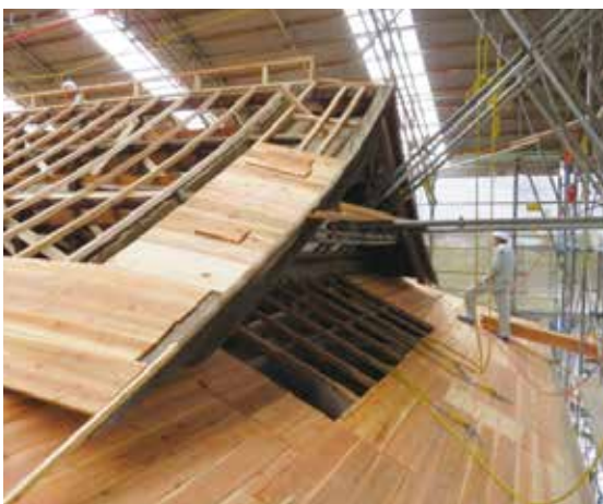
図 4-76 屋根野地板張り状況
