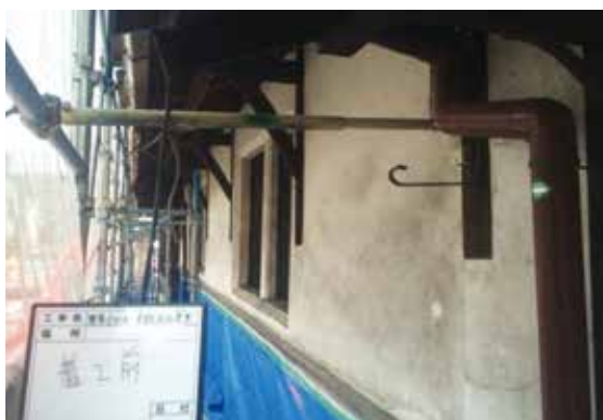
図 2-93 主屋修理前（1階外壁）
