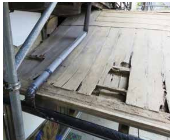
図 4-59 玄関構え屋根解体状況
