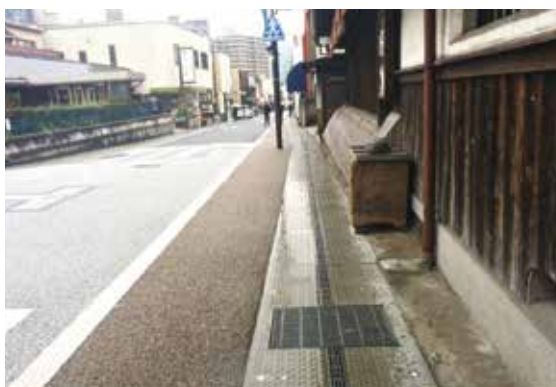
図 2-87 主屋修理前（腰板部）
