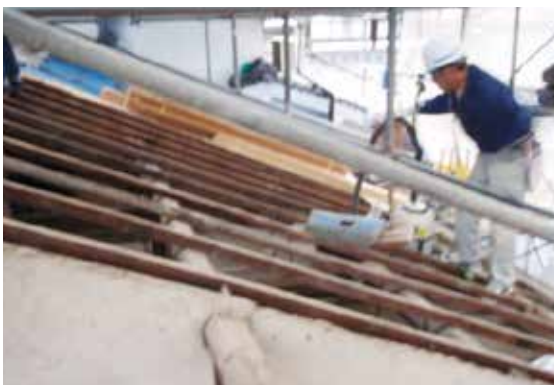
図 2-53 解体工事 (南面屋根)
