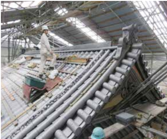
図 4-80 屋根瓦葺き状況 3
