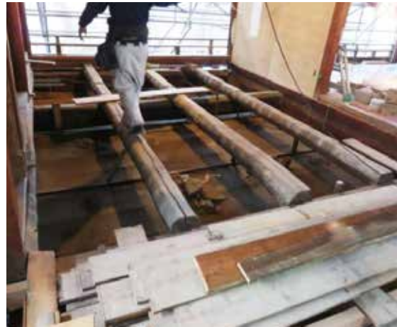
図 4-91 2階座敷の床撤去状況
