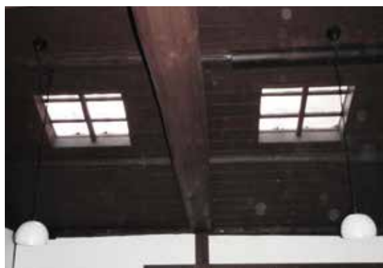
図 2-78 屋根工事 (硝子瓦の明り採り窓)
