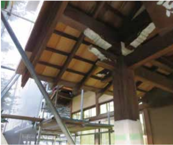
图 4-112 玄関軒裏普及箇所修理状況
