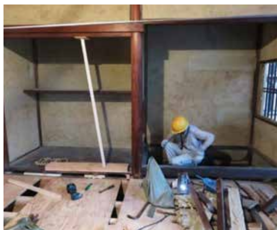
図 4-95 2階座敷床廻りレベル調整状況
