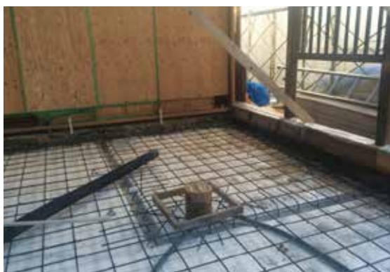
図 2-57 鉄筋工事 (内部土間)
