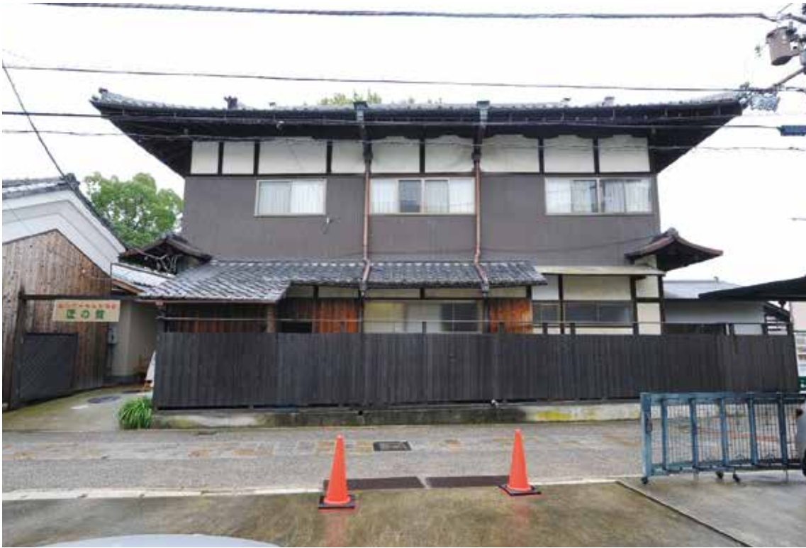
図 4-8 修理前外観（東面 平成 21 年）
