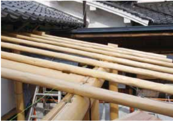
図 2-79 屋根工事 (中庭側庇)
