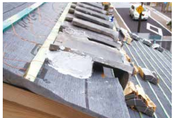
図 2-70 屋根工事（越屋根）
