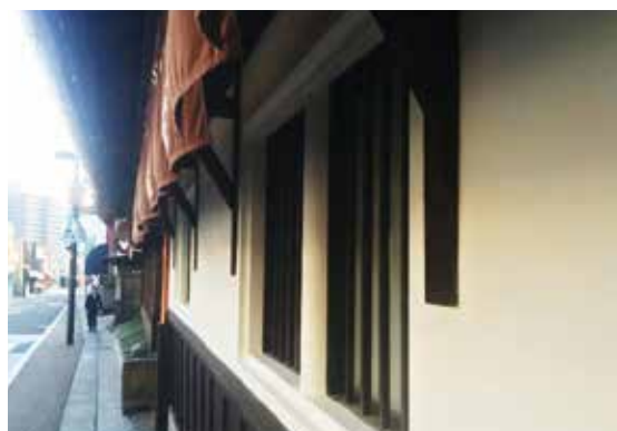
図 2-94 主屋修理後（1階外壁塗り直し）
