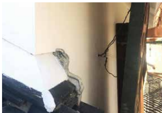
図 2-92 主屋修理後（2階北面外壁塗り直し）
