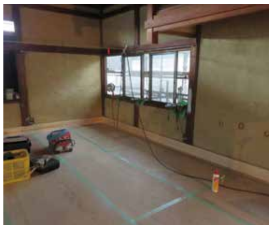
図 4-97 2階会議室造作工事 2
