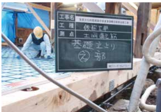
2-59 鉄筋工事 (基礎立上り)
