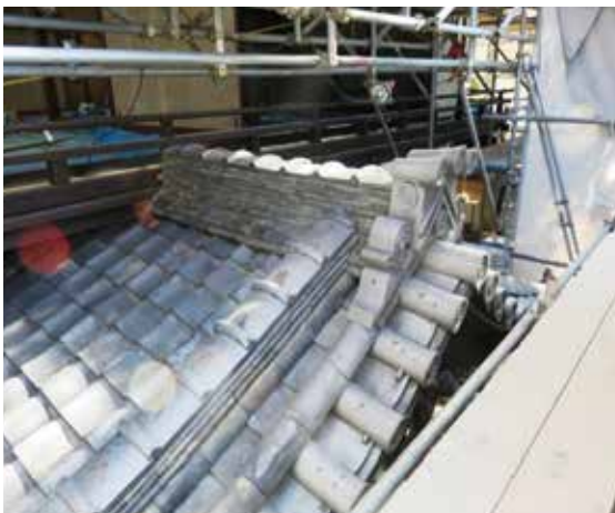
図 4-82 玄関屋根瓦葺き状況
