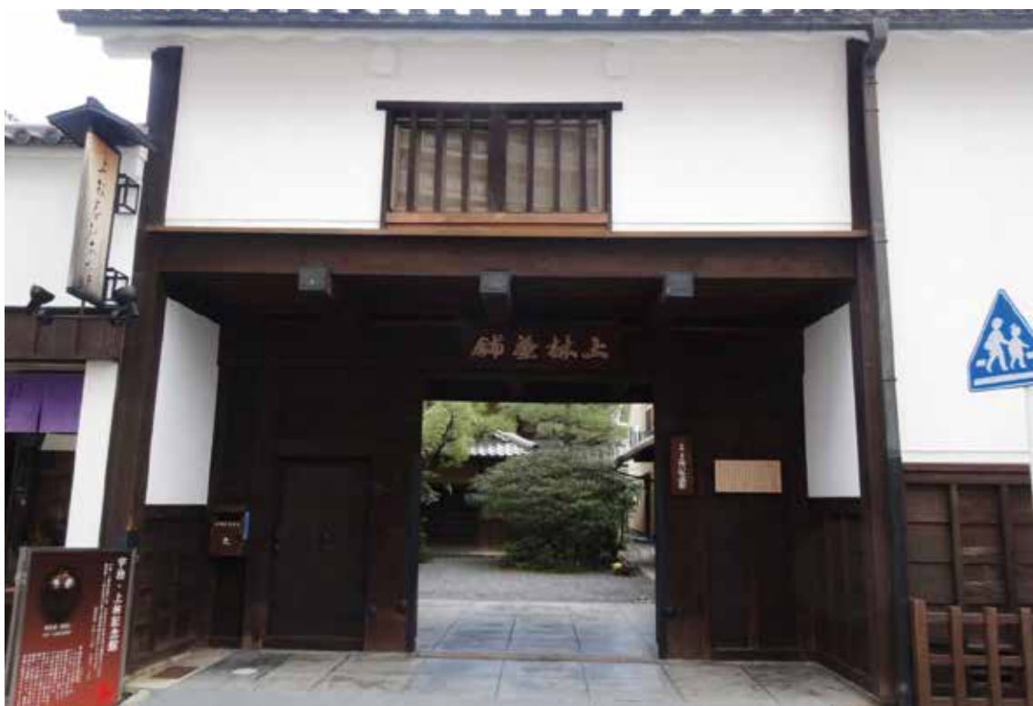
図 3-7 上林春松家長屋門外観 (平成 27 年)
