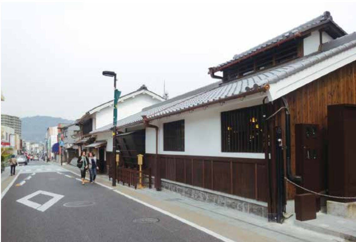
図 2-27 中村藤吉本店修理後外観（西から、平成 27 年）
