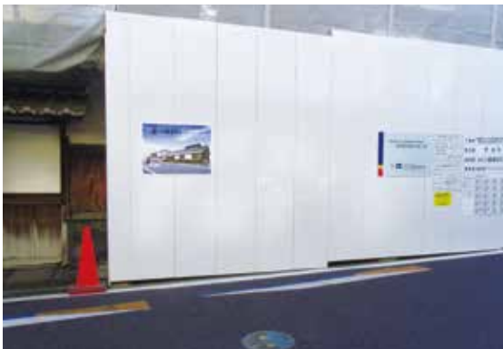
図 2-49 仮設工事 (外観 看板)
