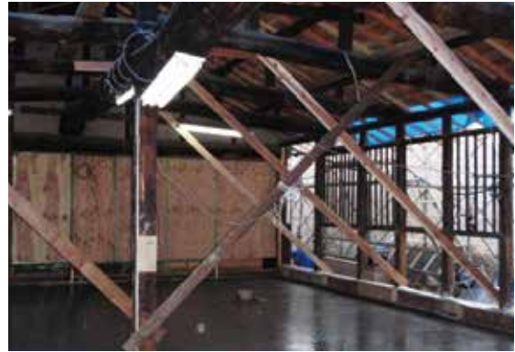
図 2-64 コンクリート工事（内部土間）
