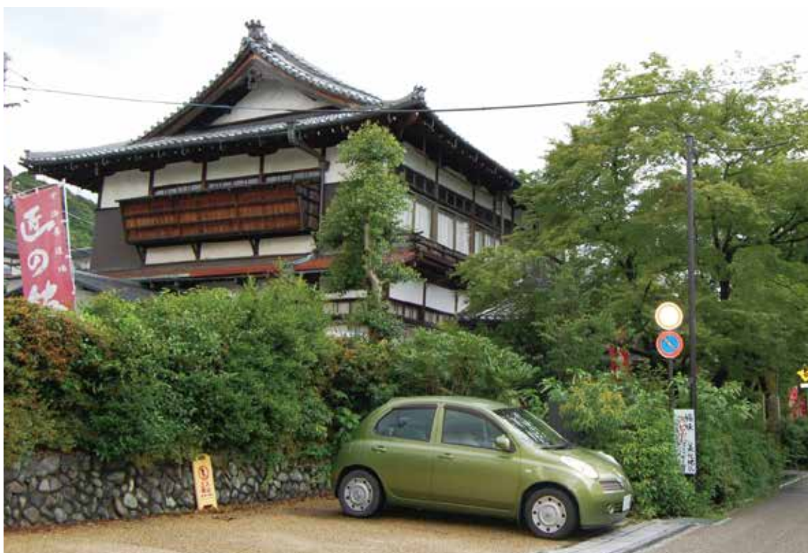
図 4-7 修理前外観（北西面 平成 27 年）
