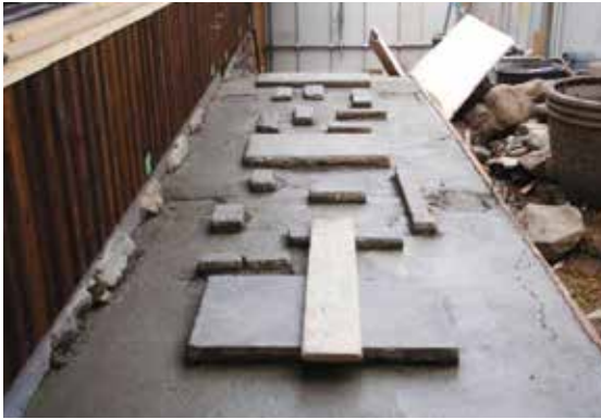
図 2-63 コンクリート工事（中庭側土間）
