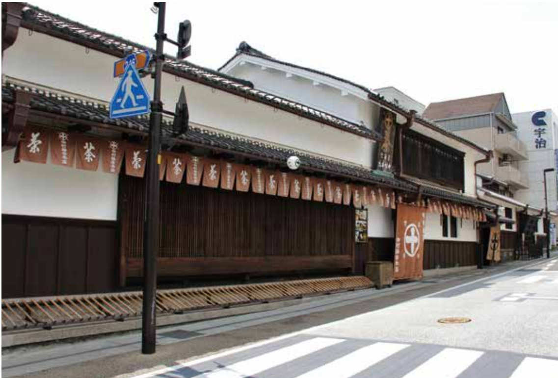
図 2-29 中村藤吉本店修理後外観（東から、平成 27 年）
