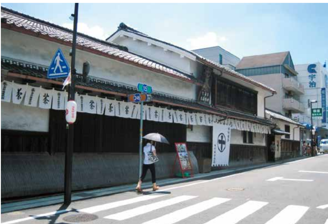
図 2-26 中村藤吉本店修理前外観（東から、平成 24 年）
