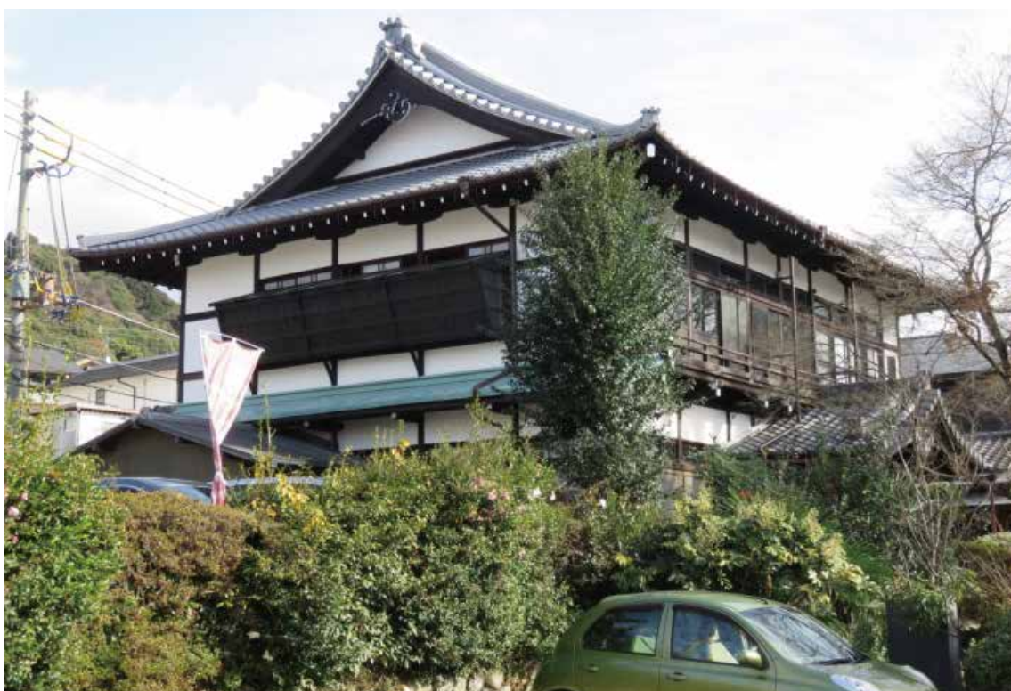
図 4-119 修理後外観（北西面）
