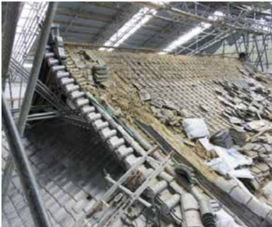
図 4-56 屋根解体状況 1
