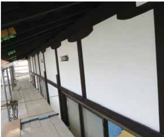
図 4-108 2階外壁漆喰塗り・木部古色完成 1
