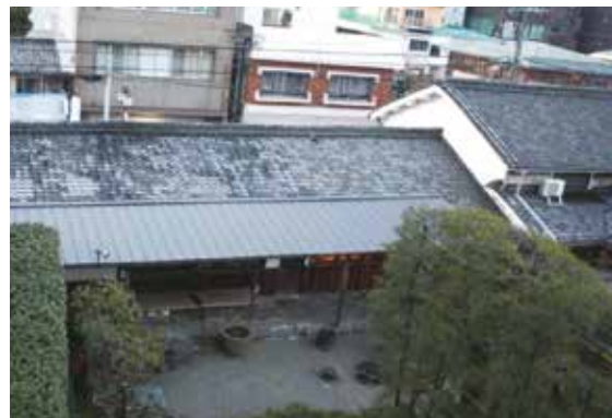
図 2-18 瓦の新旧に見る越屋根と明り採り跡
