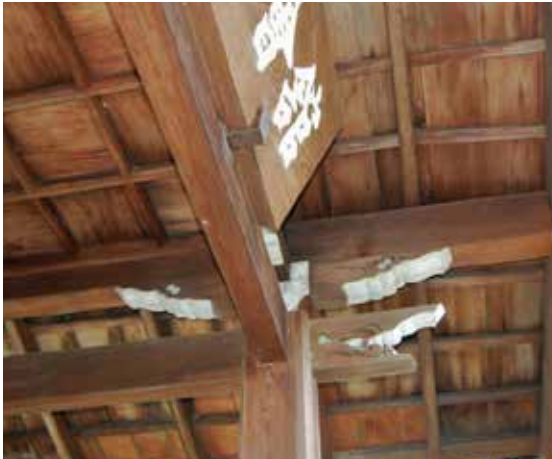
図 4-54 修理前（玄関 格縁天井の状況）
