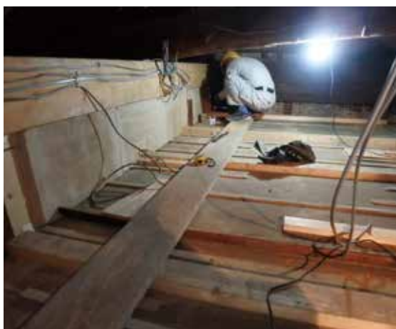
図 4-94 天井内での耐震壁構造補強の工事
