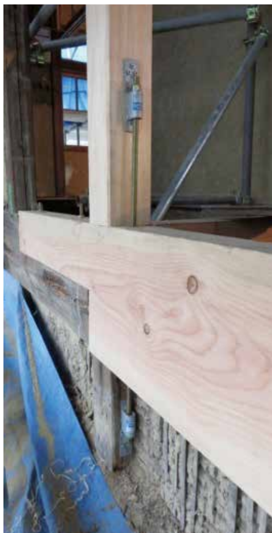
図 4-87 2階会議室東壁胴差廻り修理状況
