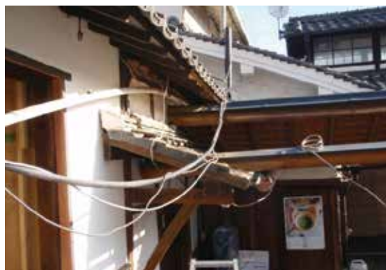
図 2-76 屋根工事 (南側庇)
