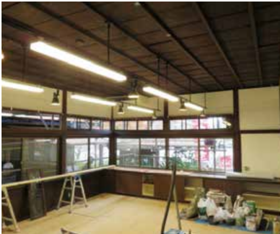
图 4-114 1階研修室1造作完了状況
