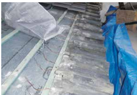
図 2-71 屋根工事 (軒先古瓦)
