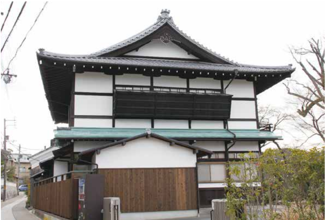
図 4-121 修理後外観（北面）
