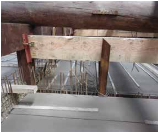
図 4-62 小屋梁構造補強状況 1
