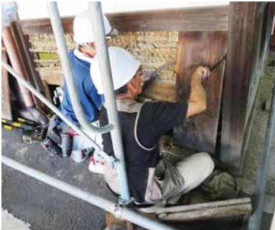
図 4-68 1階腰壁・化粧板撤去状況
