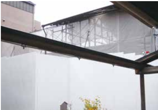
図 2-51 仮設工事 (南東側より)
