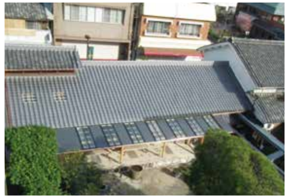
図 2-34 修理後 (外観南面)
