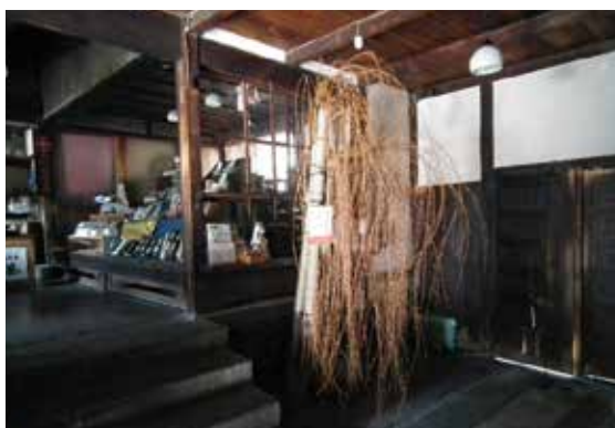
図 2-39 修理前 (通路 売場)
