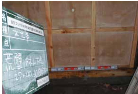
図 2-68 木工事（荒壁パネル下地）
