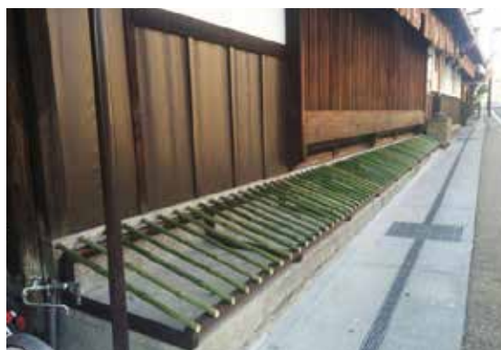
図 2-90 主屋修理後（犬矢来を大正期へ復旧）
