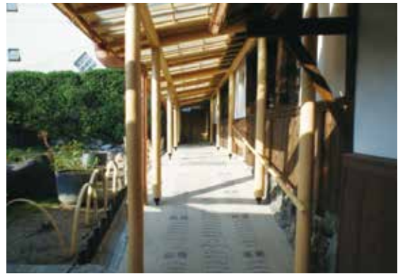
図 2-36 修理後 (中庭土間)
