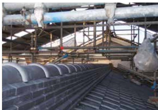
図 2-74 屋根工事 (棟瓦)
