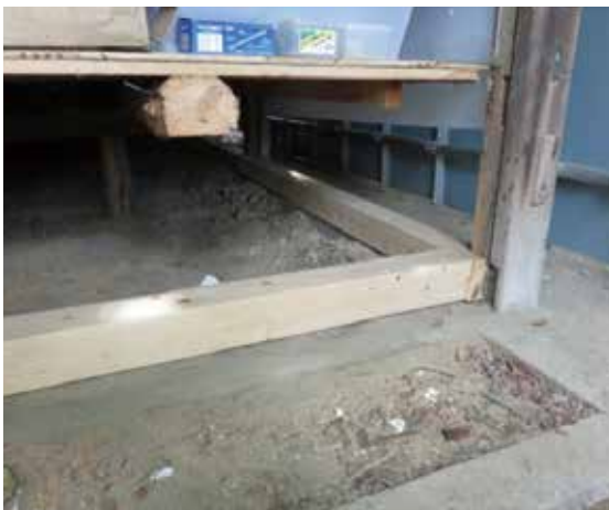
図 4-70 1階腰壁の撤去状況
