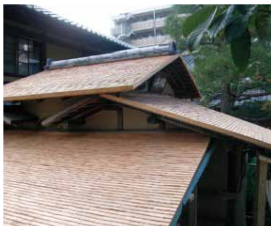
图 3-11 修理後（茶室屋根上下段）
