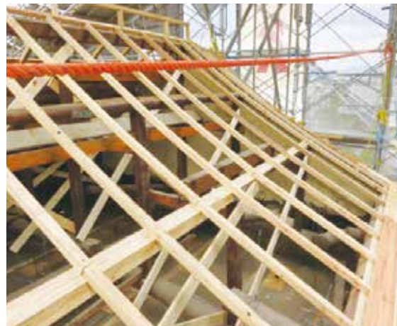
図 4-75 屋根反り手直し状況
