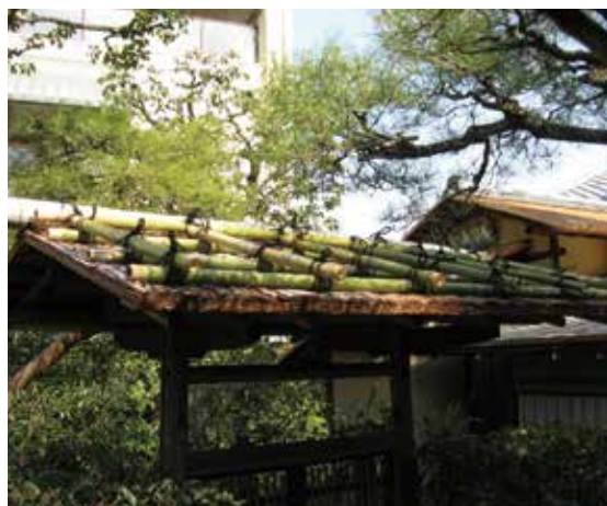
图 3-13 修理後（茶室潜り門）
