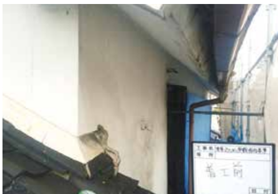
図 2-91 主屋修理前（2階北面外壁）
