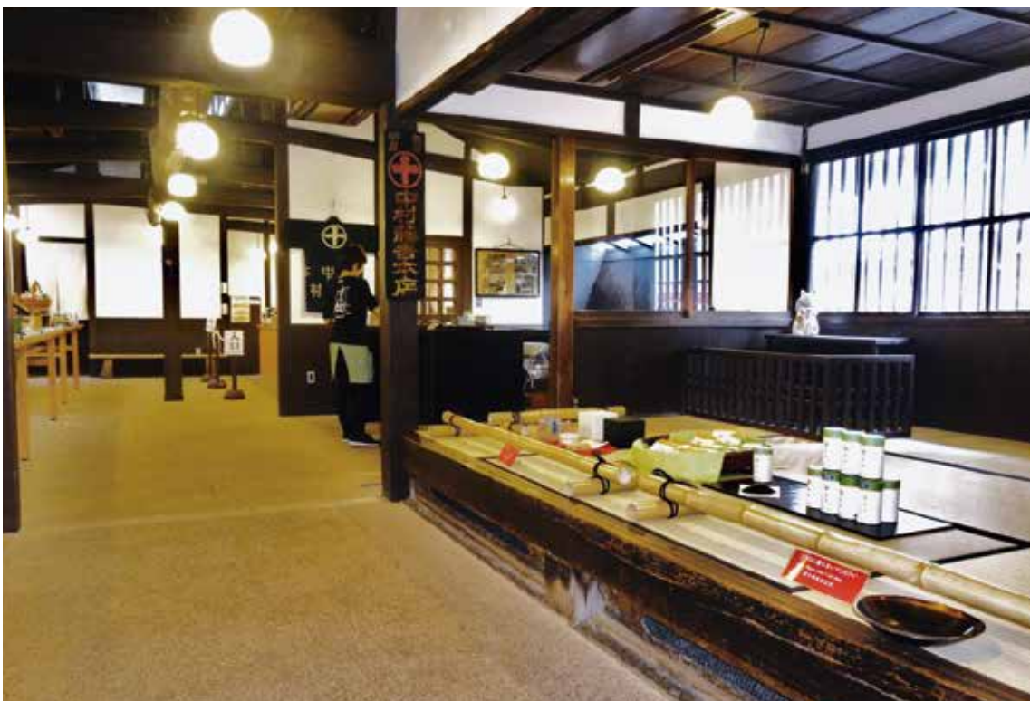
図 2-30 中村藤吉本店旧焙炉場修理後内部（東から、平成 27 年）
