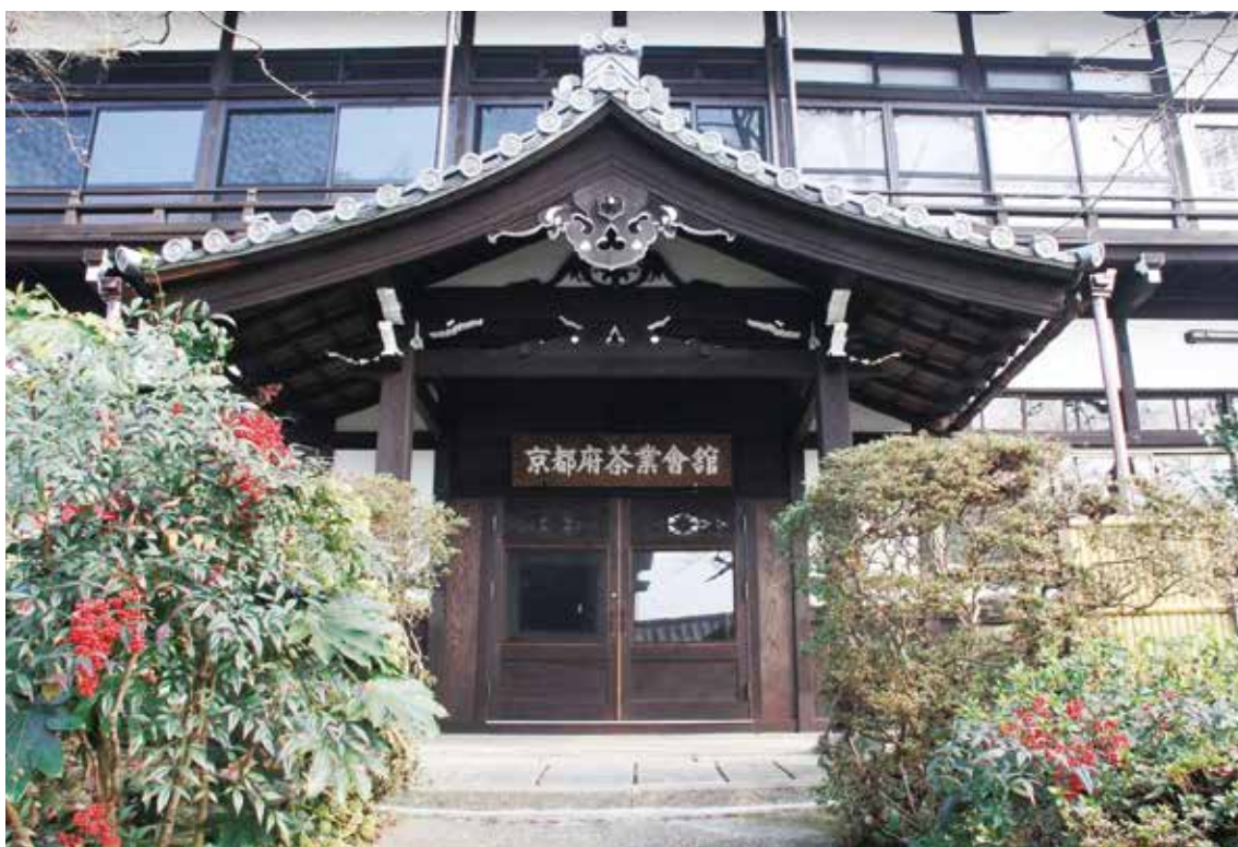
図 4-123 修理後外観（玄関）
