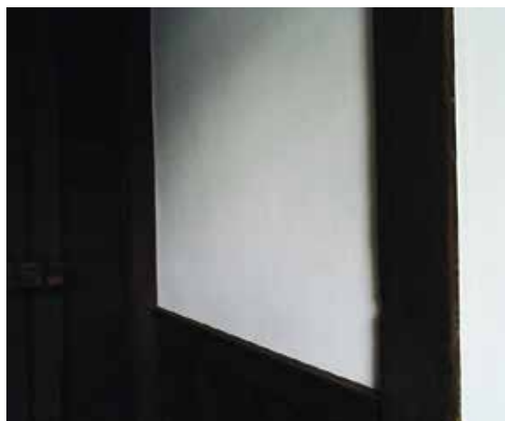
図 3-19 修理後（長屋門内側）
