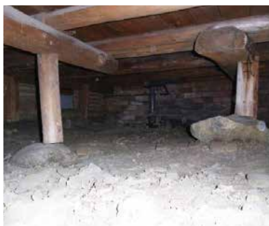
図 4-53 修理前（床束の状況）
