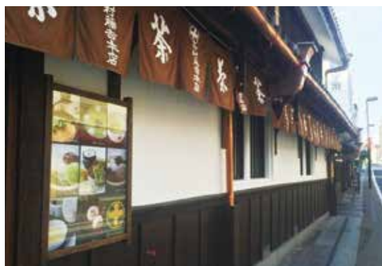
図 2-88 主屋修理後（腰板張替・壁塗り直し）
