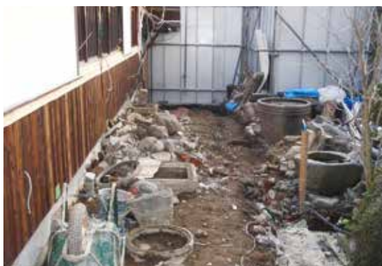
図 2-55 土工事 (中庭側土間)
