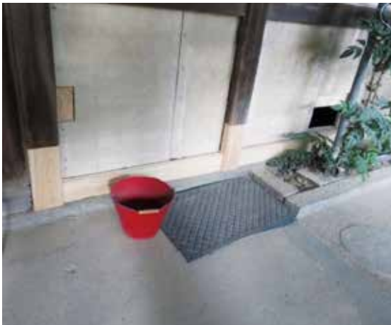
図 4-72 1階腰の柱根継・付け土台荒壁下地完了 1
