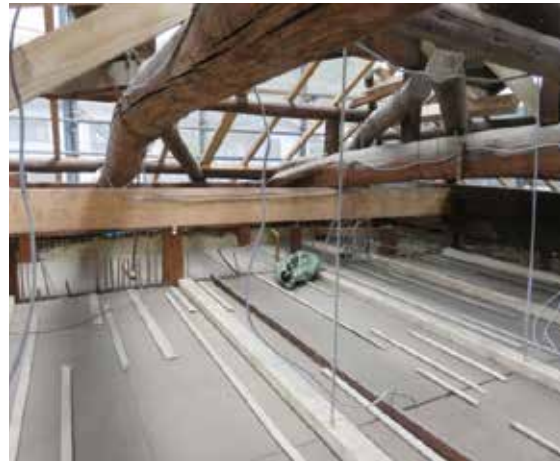
図 4-63 小屋梁構造補強状況 2
