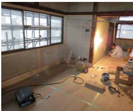
図 4-96 2階会議室造作工事 1
