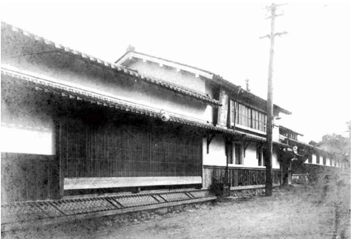
図 2-4 大正頃の古写真（拝見窓が設置されている）
