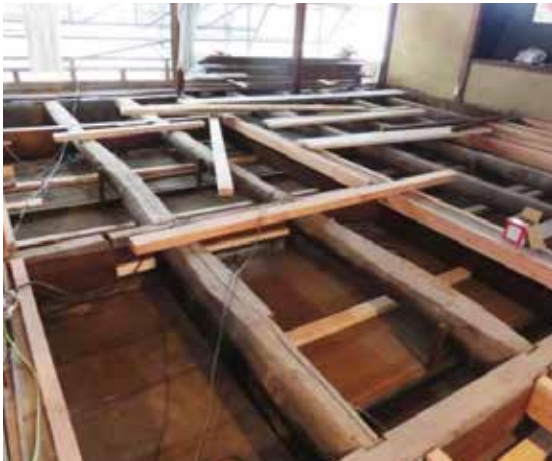
図 4-90 2階会議室の床レベル調整状況
