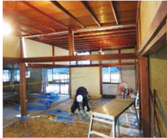
図 4-89 2階構造補強に伴う垂壁撤去状況
