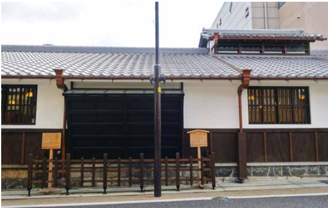
図 2-23 再現した拝見窓と囲いの駒寄せ・越屋根等の外観（平成 26 年）
