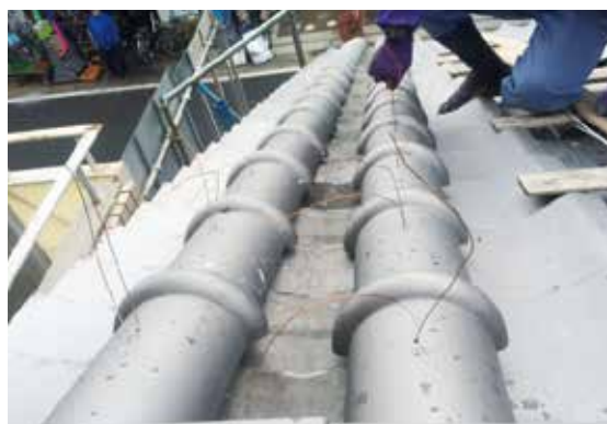
図 2-72 屋根工事 (端部丸瓦)
