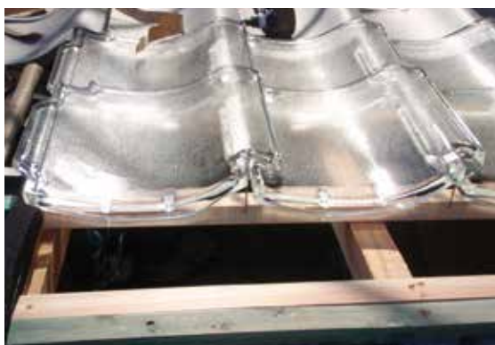
図 2-77 屋根工事 (硝子瓦)
