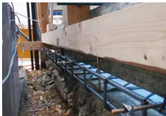
図 2-60 鉄筋工事 (基礎立上り)
