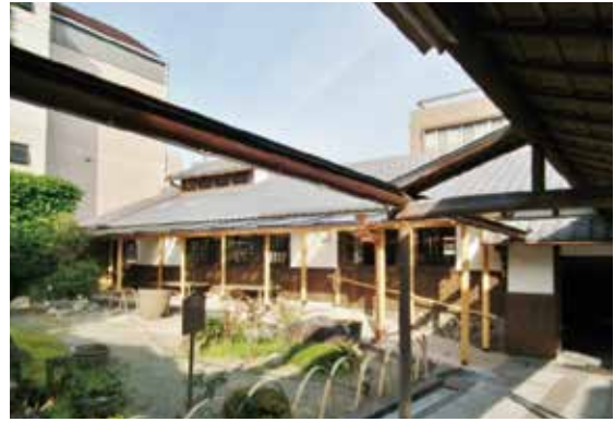
図 2-32 修理後 (外観南面)
