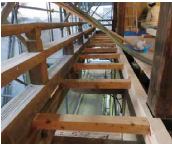
図 4-104 2階濡縁床下地取替え状況
