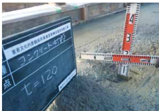
図 2-62 コンクリート工事 (コンクリート打設)
