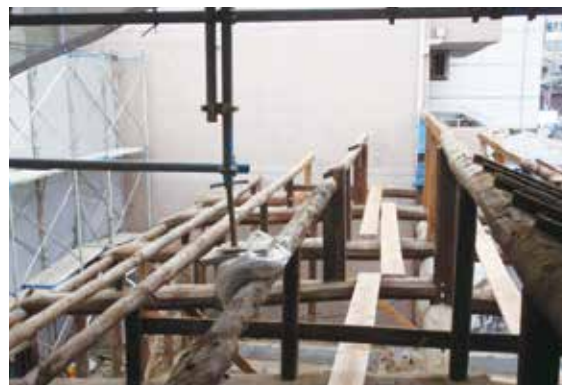
図 2-54 解体工事 (南面屋根)
