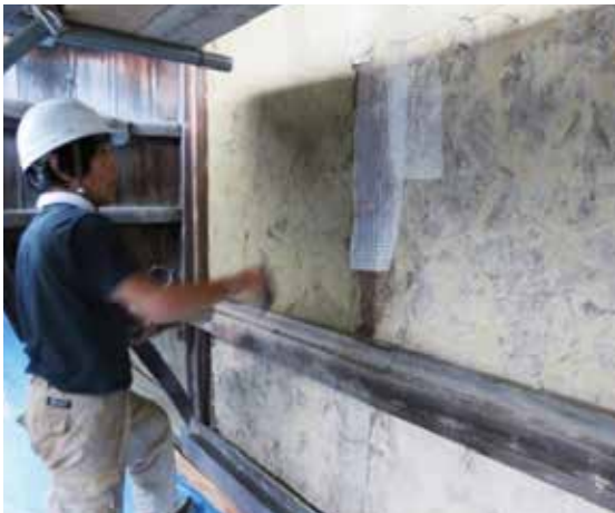
図 4-106 2階外壁漆喰下地補修工事
