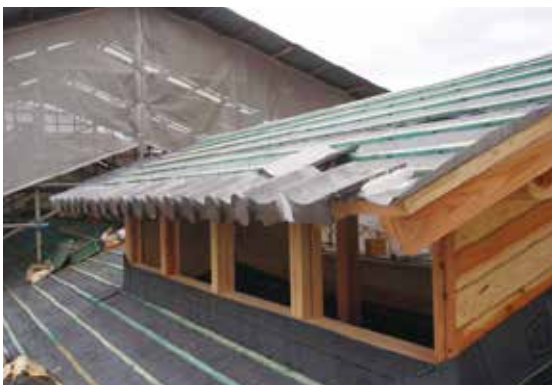
図 2-69 屋根工事（越屋根）
