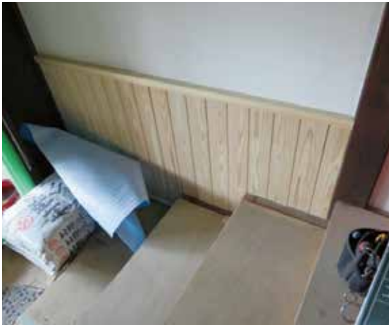
図 4-102 玄関腰壁耐震補強完了状況
