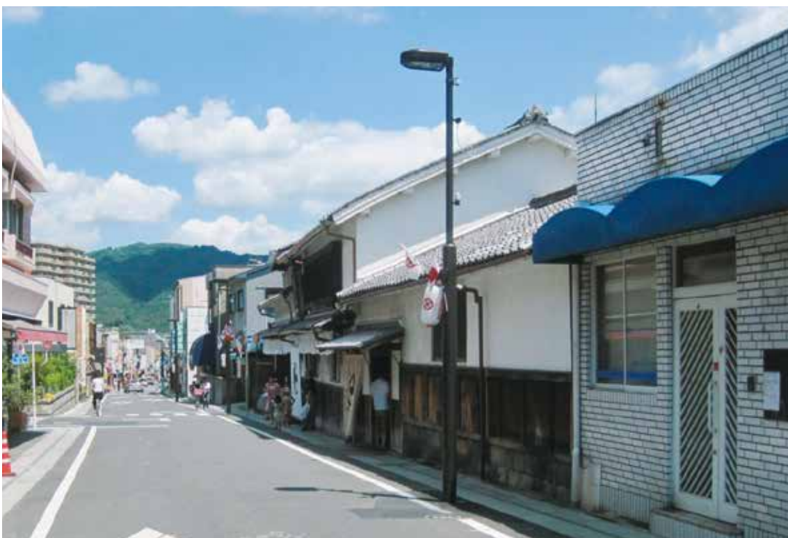
図 2-25 中村藤吉本店修理前外観（西から、平成 24 年）
