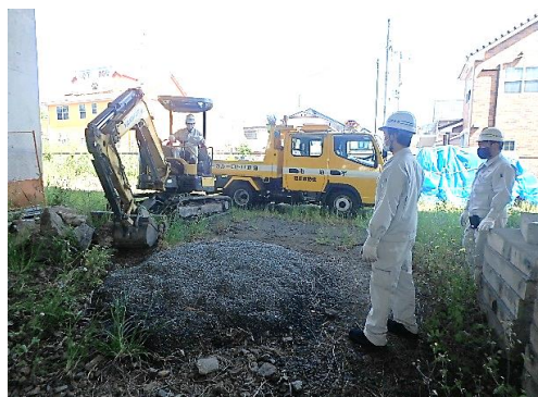
機動修理班による作業状況
