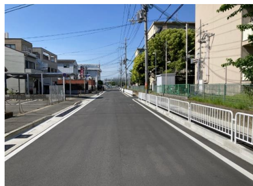
大久保町 6 号線（歩道改修工事）
