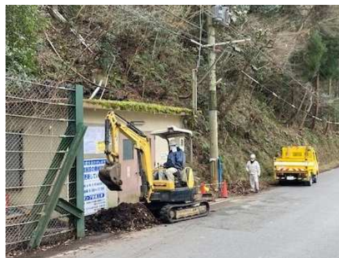
機動修理班による作業状況
