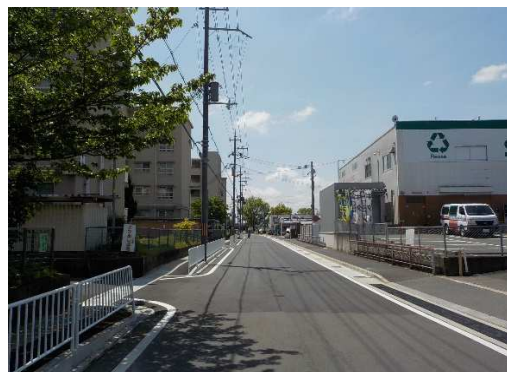
大久保町6号線（歩道改修工事）
