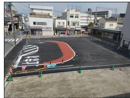
駅前広場（西口）暫定整備
