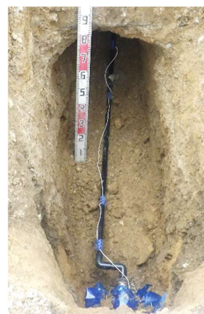
布設替え完了 （遠景写真）
