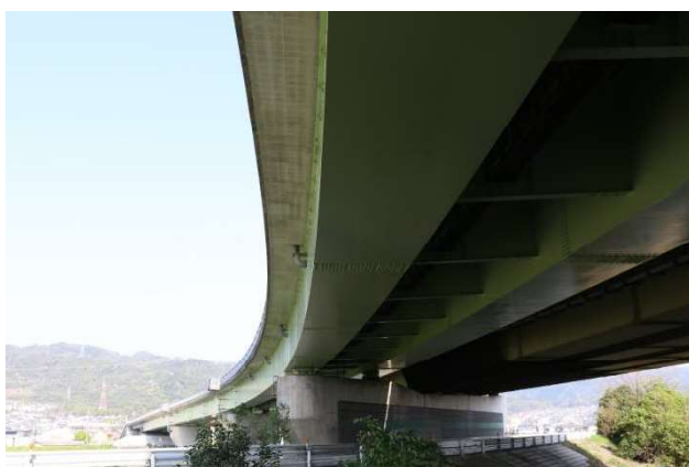
宇治川橋（槇島町郡～槇島町大島）
