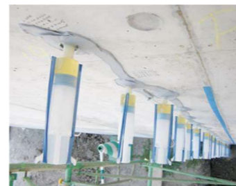
ひび割れ注入工
