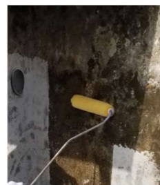
塗布型当て板工
