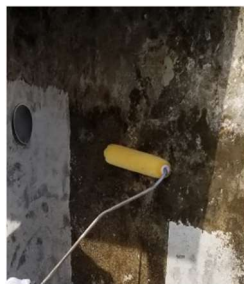
【塗布型当て板工】
