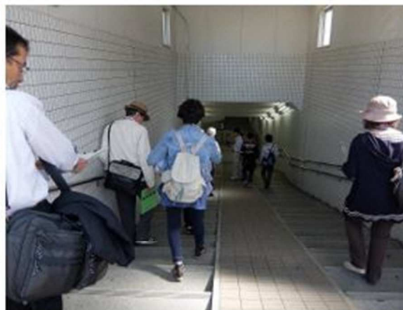
【近鉄伊勢田駅地下通路】
