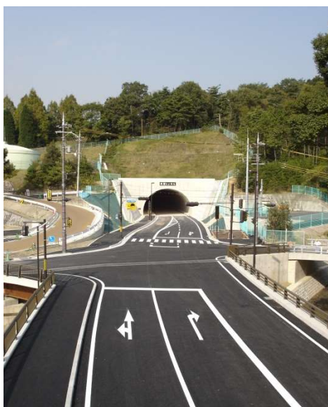
[ 黄檗山手線 平成 16 年 11 月 3 日 全線開通 ]
