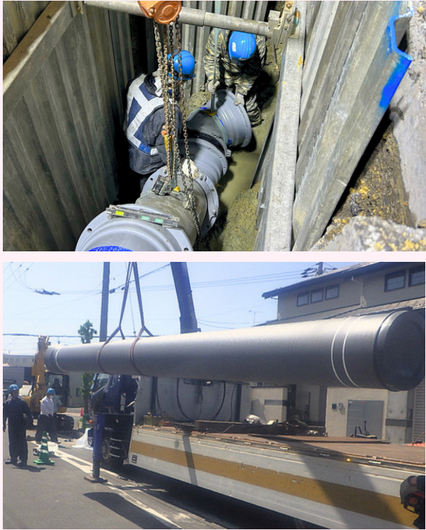
新しい水道管を設置している様子
