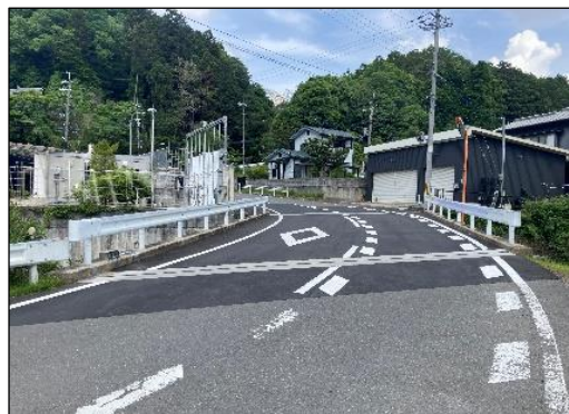
< 養老橋（橋梁修繕工事） >
