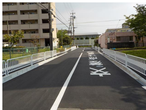
大久保町30号線（歩道改修工事）
