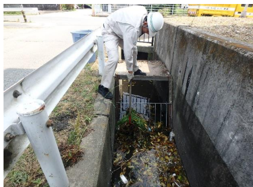
機動修理班による道路維持作業
