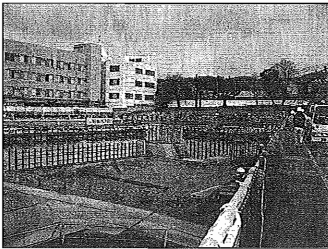
<(仮)第一小中一貫校建設現場> 平成22年11月撮影
